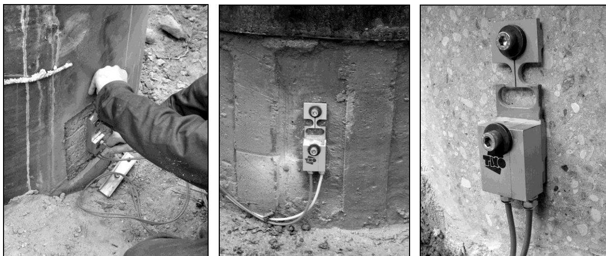
Rys. 4. Czujniki zamontowane na palu
