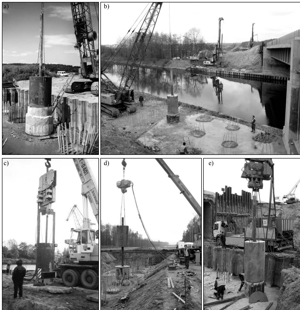
Rys. 5. Dynamiczne badania nośności pały wierconych:
