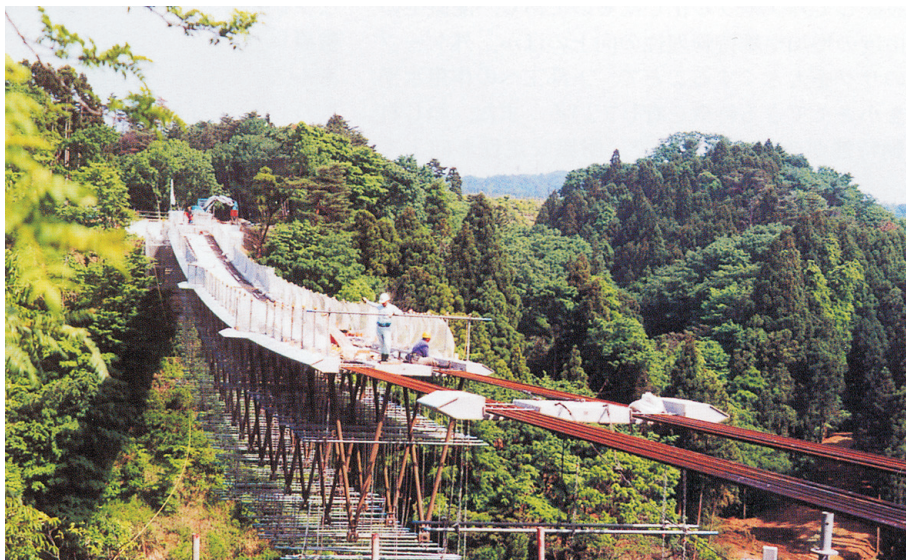
Rys.6. Montaż kładki [6]
