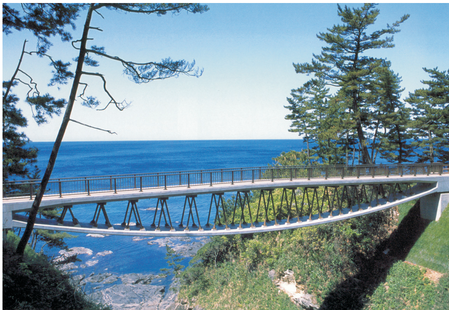
Rys.13. Kładka ukończona [6] Fig.13. Completed footway bridge [6]
