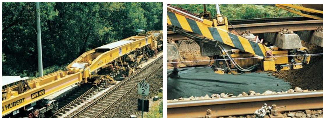
Rys. 10. Schemat maszyny SVV100 oraz widok układanego wzmocnienia[2]
