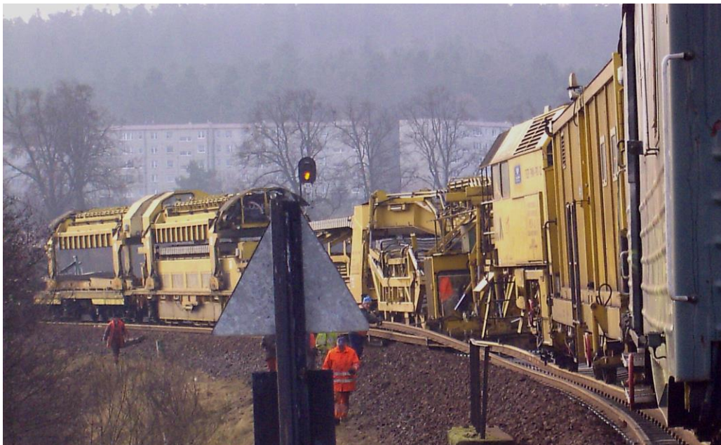
Rys. 1. Pociąg do wymiany nawierzchni P-93 podczas pracy
