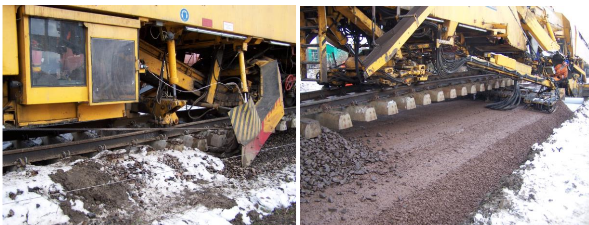
Rys. 4. Wybieranie warstwy podtorza (z lewej) i wbudowanie warstwy wzmacniającej (z prawej)
