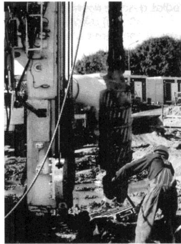
Rys. 2. Konstrukcja świdra do wykonywania pali wkręcanych
