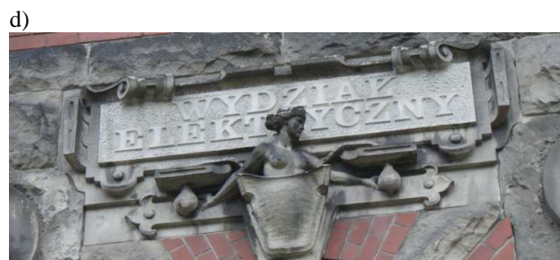
Rys. 2. Widok dzienny iluminowanej elewacji i wyróżnienie charakterystycznych jej elementów: a) widok ogólny, b) tarcza ze znakiem „+”, c) dekoracja narożna – salamandry, d) kartusz z napisem „Wydział Elektryczny”
