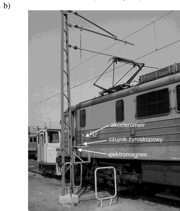
Rys. 12. Eksperymentalne terenowe stanowisko do badania stanu zawieszania ślizgacza: a) szkic konstrukcyjny, b) widok stanowiska
