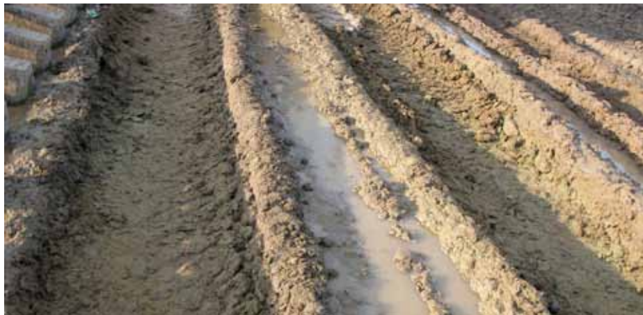
1. Widok gruntu przed stabilizacją
