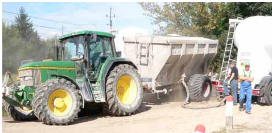
3. Załadunek spoiwa do rozsypywacza
