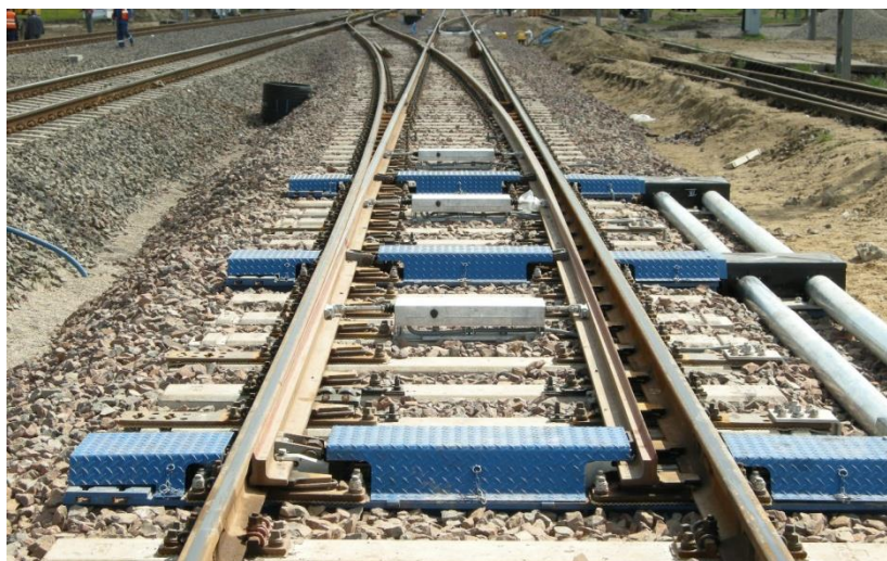
Fot. 2. Rozjazd zwyczajny lewy o promieniu 760 m
