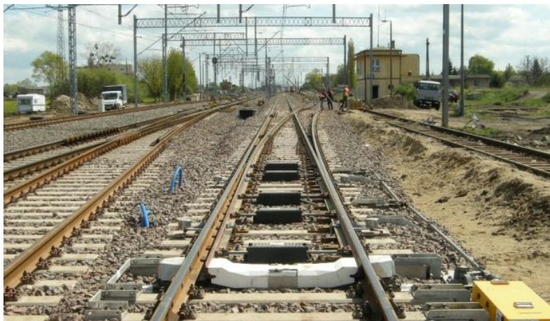
Fot. 1. Rozjazd zwyczajny prawy o promieniu 760 m
