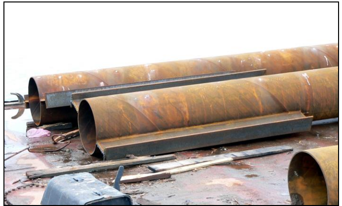
Rys. 5. Pali rurowe z dospawanymi „skrzydełkami”
