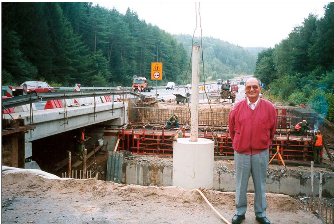
Rys. 2. Prof. A. Tejchman na tle stanowiska do badania dynamicznego nośności pąła wierconego \phi 1200 mm, Obwodnica Trójmiasta, wiadukt 4B
