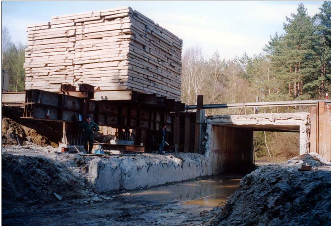
Rys. 2. Stanowisko do badania statycznego nośności pąła wierconego \phi 1200 mm, Obwodnica Trójmiasta, wiadukt 4A
