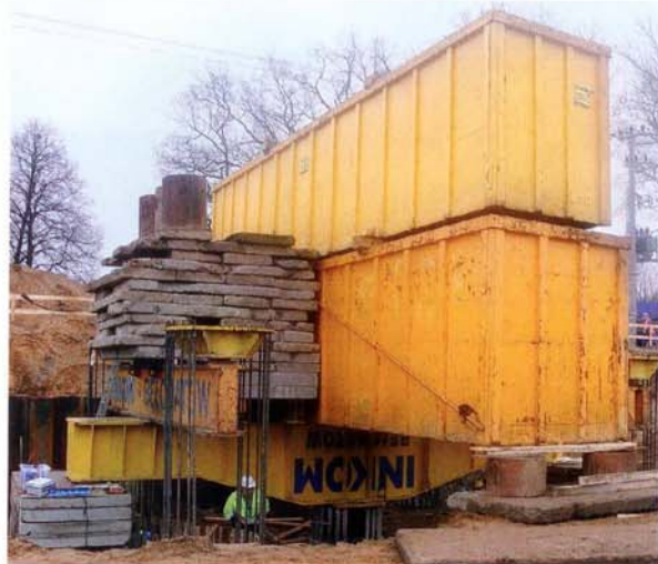
Fot. 1. Fotografie z próbnego obciążenia palia fundamentu mostu MA21 we Wrocławiu
