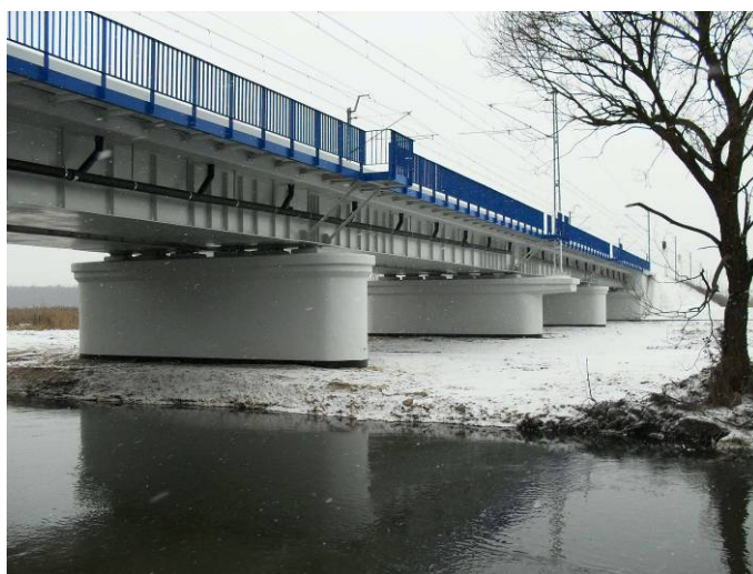
Rys. 11. Widok ogólny mostu po wykonanej modernizacji
