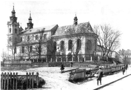
Rys. 5. Dawny stan kościoła oraz terenu, elewacja boczna od południowego wschodu (Czerner O., fot. wg [3]) Fig. 5. Former state of the church and the church site, lateral elevation to southeast (Czerner O., photo by [3])
