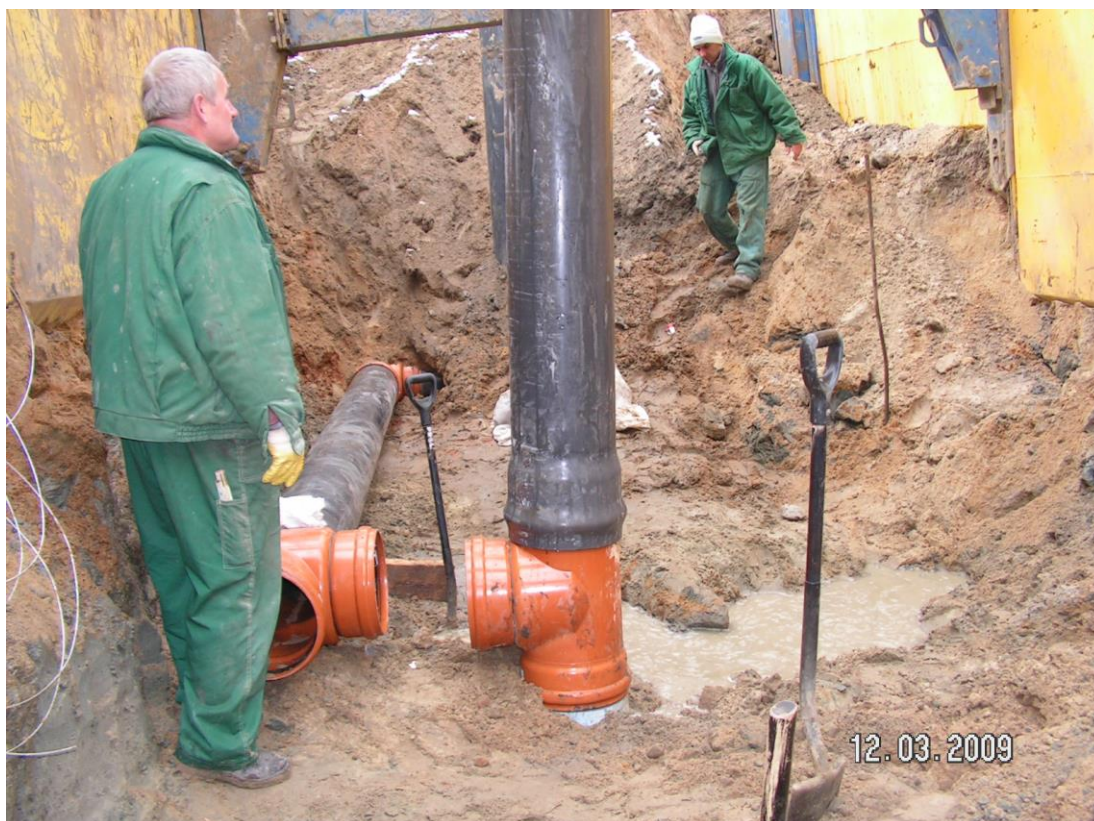
Rys. 6. Połączenie studni z kolektorem
