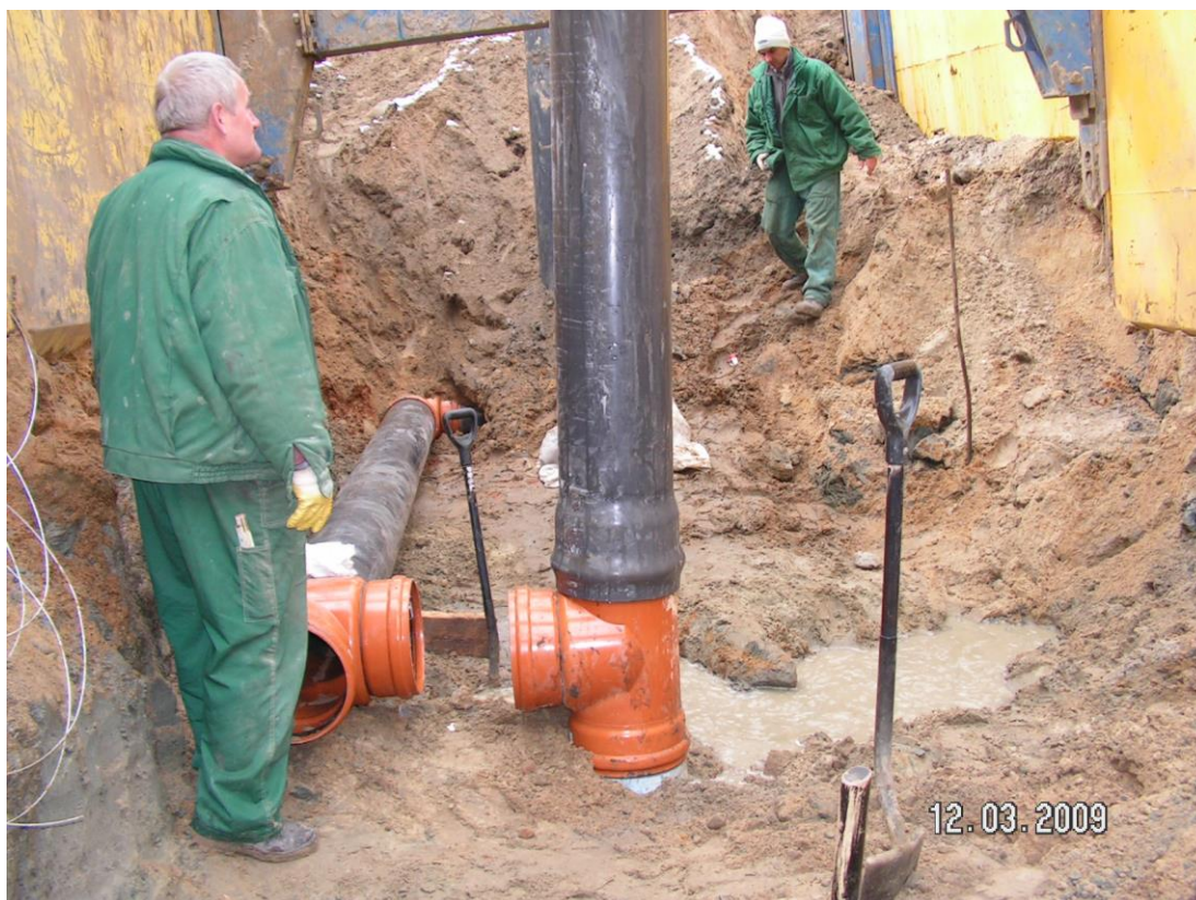
Rys. 6. Połączenie studni z kolektorem
