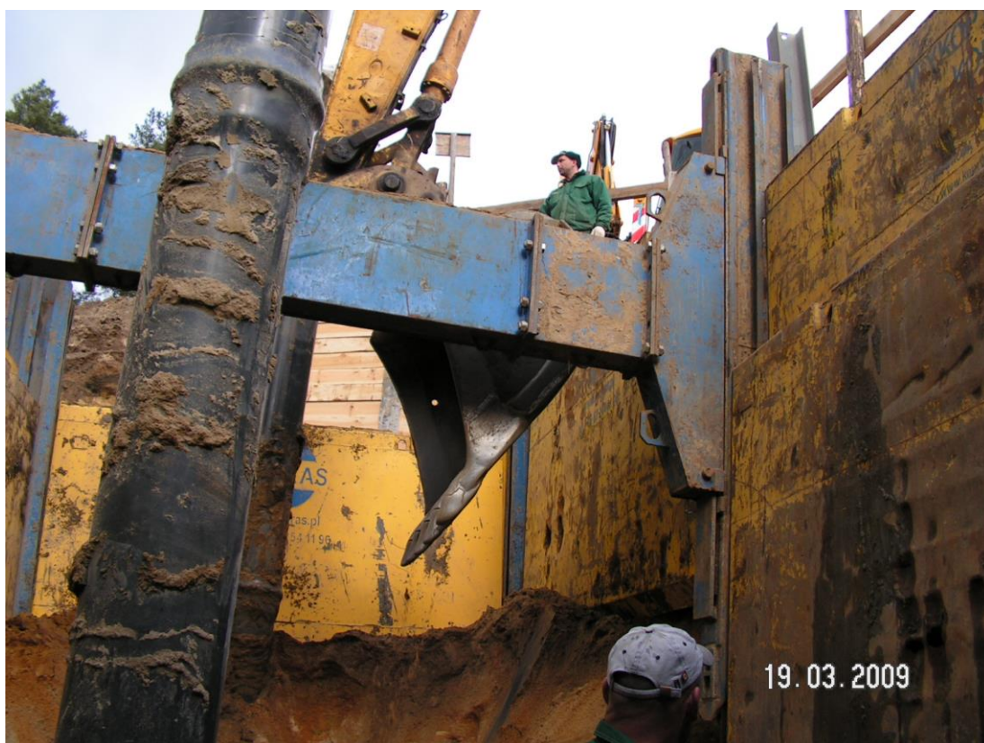
Rys. 5. Rozparcie wykopu
