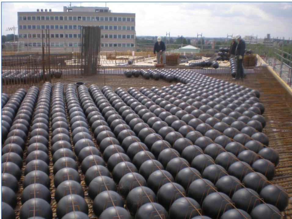
**Abb. 1: Eingebaute cobiax-Hohlkörpermodule, System cobiax Eco-Line vor Einbau der oberen Bewehrung und Betonage (Neubau eines Bürogebäudes in Bremen)**
