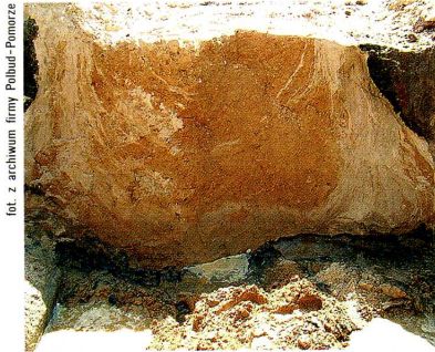
Fot. 2. Kolumna uformowana z kruszywa w gruncie słabonośnym
