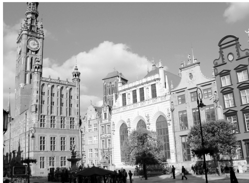
Ryc. 10. Część Długiego Targu w Gdańsku, z prawej strony Dworu Artusa widoczna nowa elewacja Nowego Domu Ławy. Stan z września 2003 r. (fot. K. Darecka)
