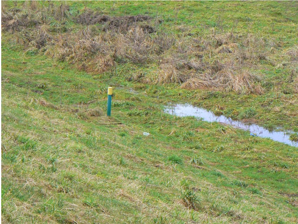
Rys. 5 – Obszar podmokły w podstawie skarpy odpowietrznej zapory nr 1
