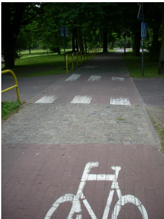
Fot.15. Zmiana koloru i rodzaju nawierzchni ścieżki rowerowej przed przejściem dla pieszych.
