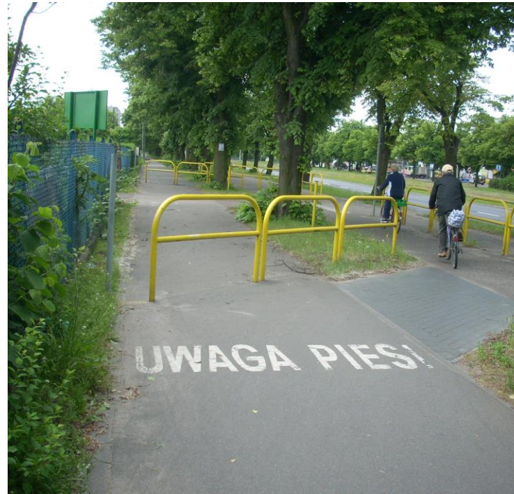
Fot.14. Napisy UWAGA PIESI! oraz żółte barierki zmieniające trajektorię ruchu rowerzysty przed przejściem dla pieszych.
