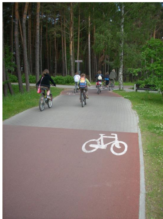
Fot.16. Zmiana rodzaju i koloru nawierzchni oraz „garby” na ścieżce rowerowej przed przejściem dla pieszych.
