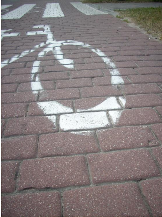
Fot.3. Nawierzchnia ścieżki rowerowej z kostki brukowej z frezem.
