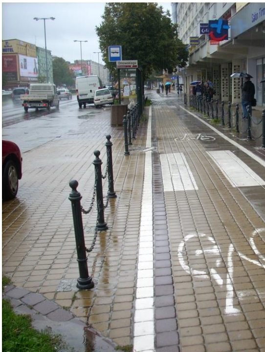
Fot.11. Ścieżka rowerowa przy al. Grunwaldzkiej oddzielona od ciągu pieszego metalowymi słupkami.
