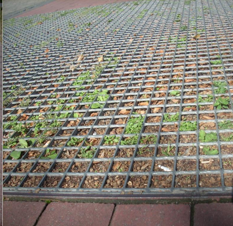
Fot.4. Przepuszczalna nawierzchnia z metalowych krat
