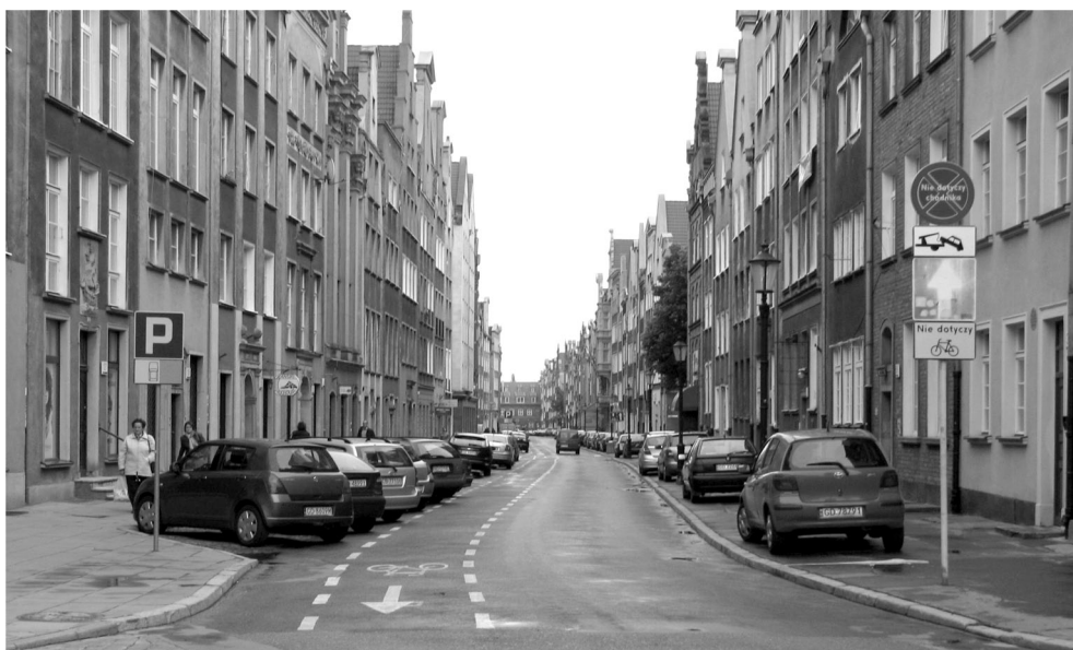
Fot. 1. Pas dla ruchu rowerowego w przeciwnym kierunku wyznaczony na ulicy jednokierunkowej w Gdańsku (fot. A. Gołędzinowska)
