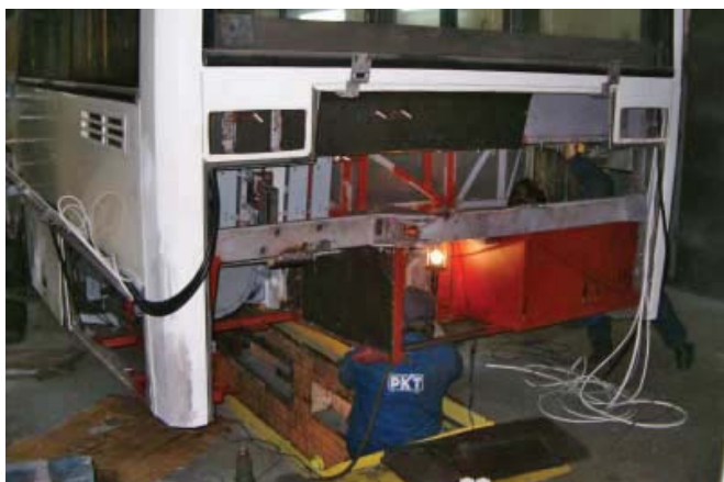
Fot. 05.jpg: Przygotowanie konstrukcji pod zabudowę aparatury napędu elektrycznego w dawnej komorze silnika spalinowego, w pierwszym egzemplarzu trolejbusu MB O405N2, Gdynia, zajezdnia trolejbusowa w Redłowie, 21.10.2004 r.
