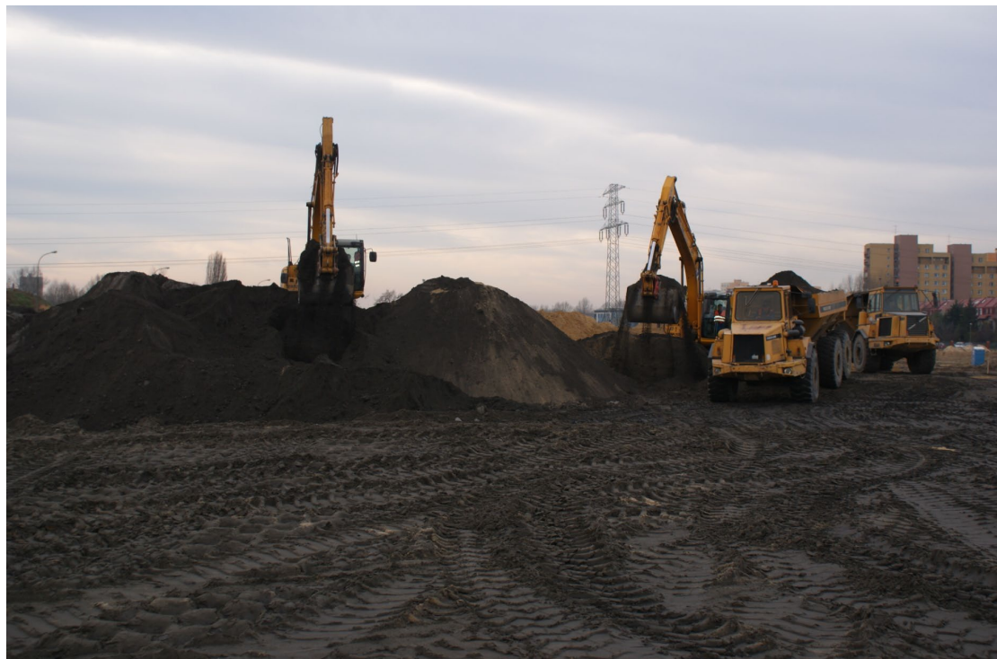
Zdjęcie 3. Najprostszy sposób mieszania UPS z piaskiem – za pomocą koparek
