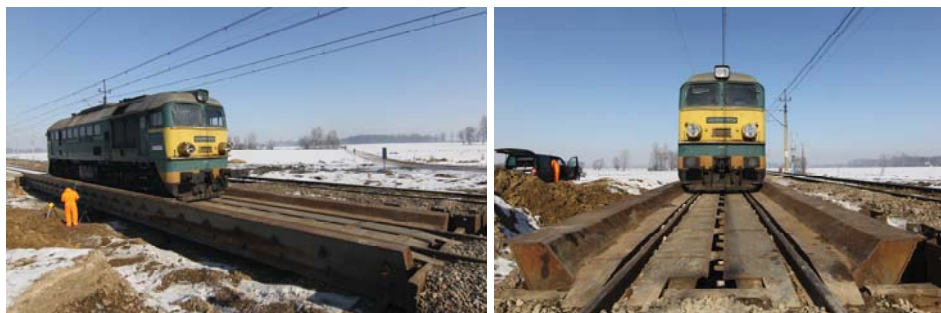
Rys.3. Widok ogólny konstrukcji odciążającej KO82
