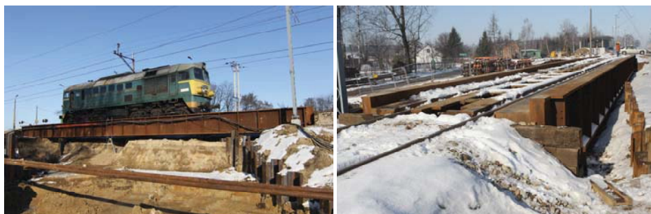
Rys.1. Widok ogólny konstrukcji odciążającej KO85
