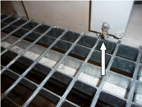
Rys. 9. Połączenie wyrównawcze ościeżnicy z przewodem uziemiającym
