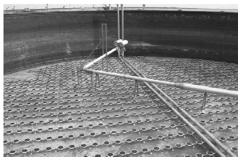
Rys. 6. Rozmieszczenie dyfuzorów na dnie reaktora SBR
