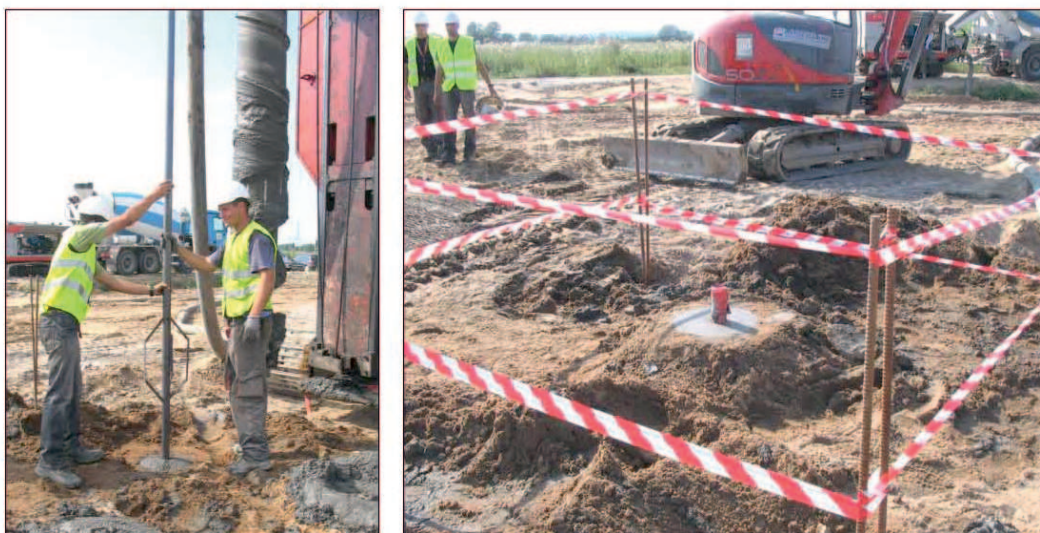
Fig. 5. Insertion of measuring equipment pipe and fully prepared pile. Rys. 5. Wprowadzanie rurki pomiarowej do pala oraz w pełni wykonany pal badawczy
