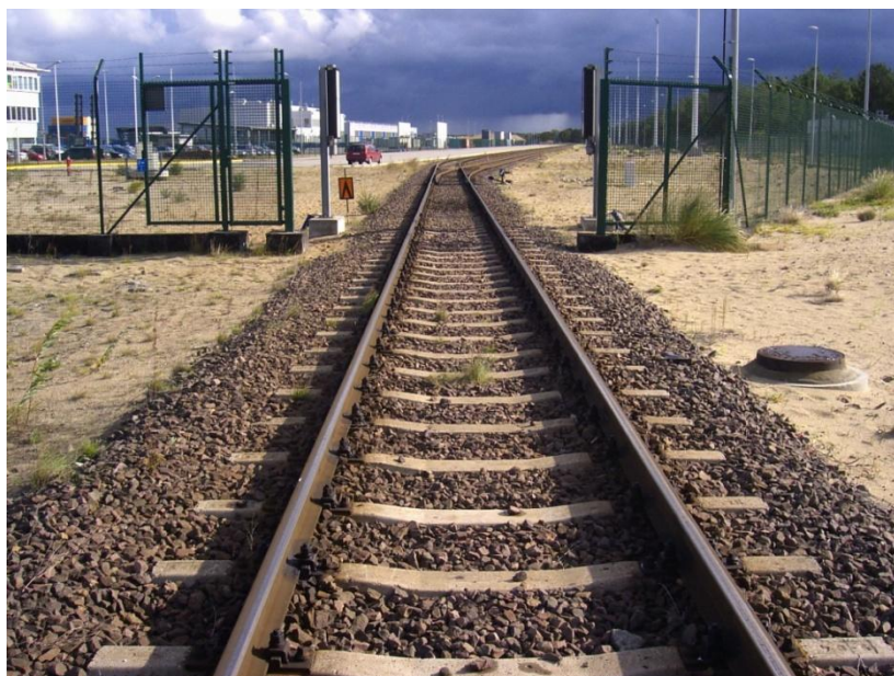
Fot.3. Wjazd na bocznicę terminala DCT
