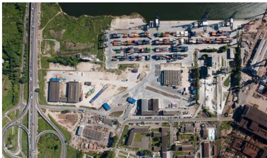
Fot.6. Terminal kontenerowy GTC [11]
