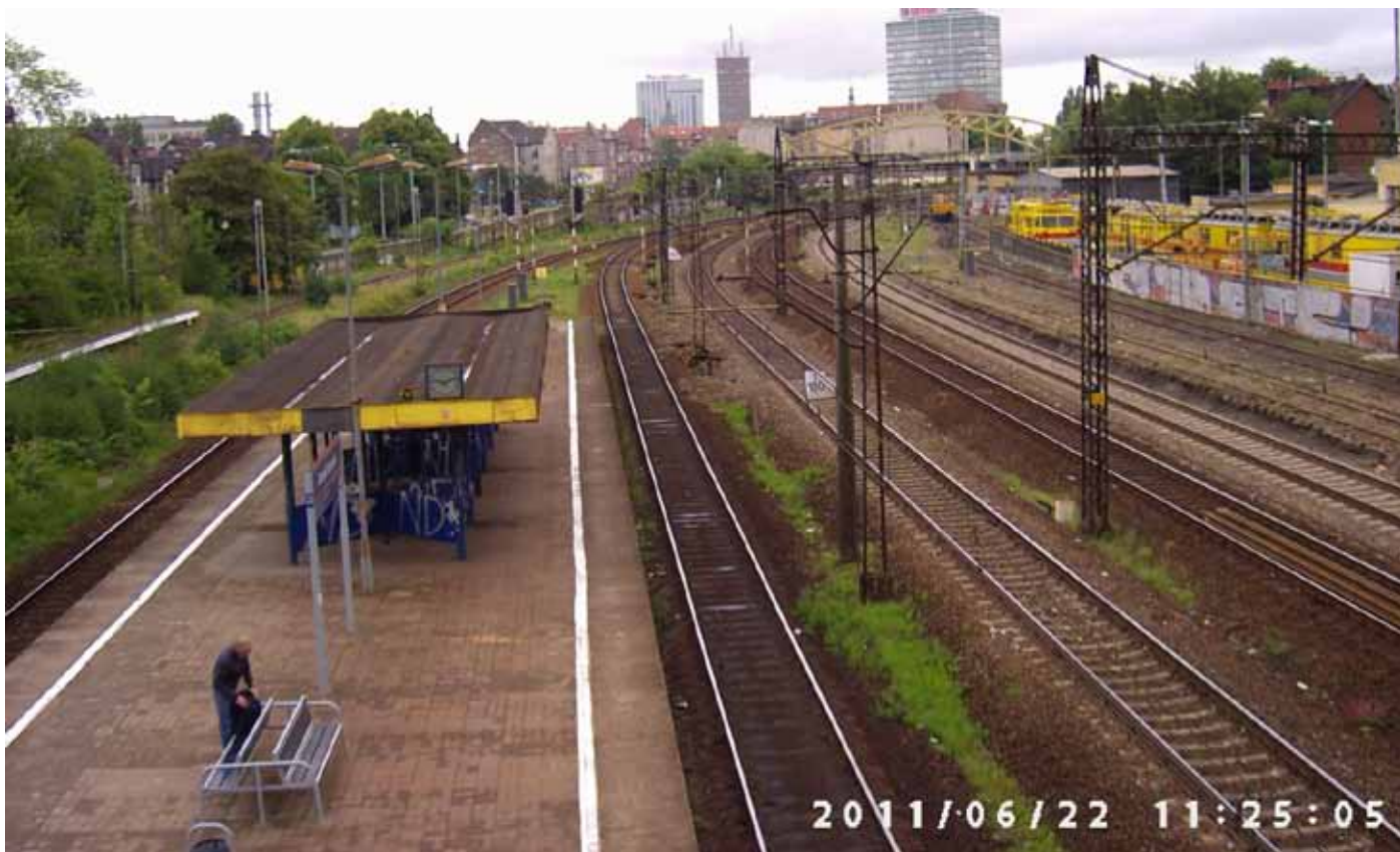
1. Przykład fotografii orientacyjnej – widoczny peron, słupy trakcyjne, tory i inne elementy ułatwiające orientację w terenie – zdjęcie wykonane z kładki dla pieszych
