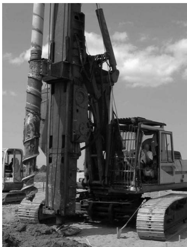
Rys. 1. Palownica do pali wkręcanych
