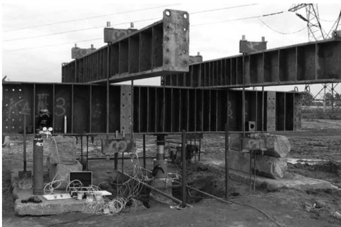
Rys. 6. Stanowisko do badań statycznych nośności pali na polu doświadczalnym
