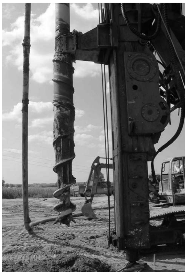
Rys. 10. Poletko OPG 1- świder CMC \phi 400 mm
