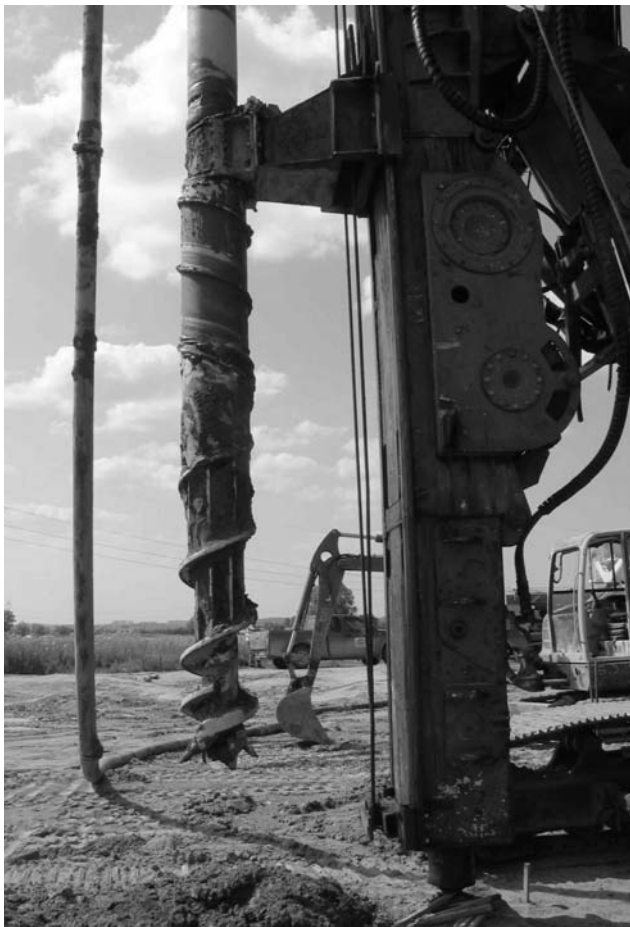
Rys. 10. Poletko OPG 1- świder CMC \phi 400 mm
