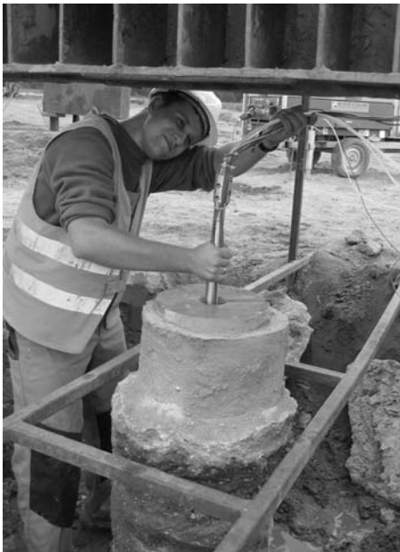
Rys. 5. Wprowadzanie łańcucha pomiarowego do wnętrza pali oraz widok głowicy pali z oprzyrządowaniem pomiarowym
