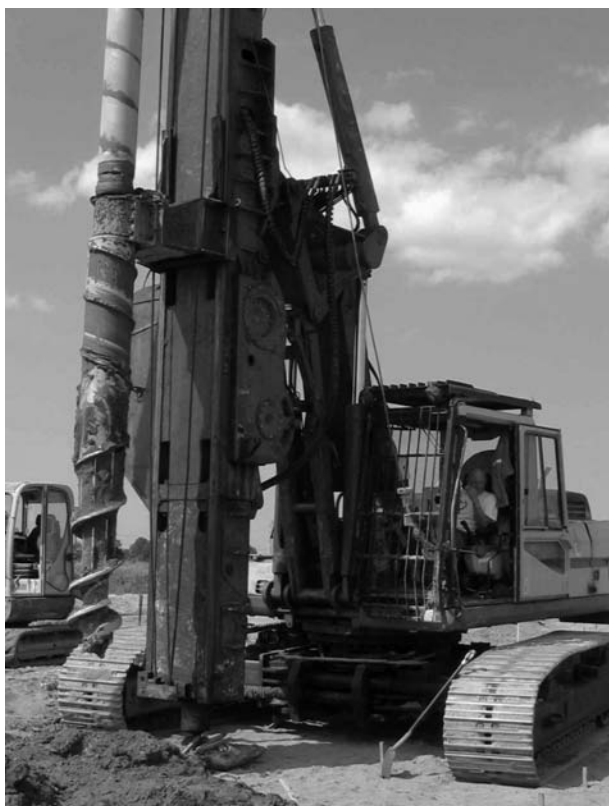
Rys. 1. Palownica do pali wkręcanych
