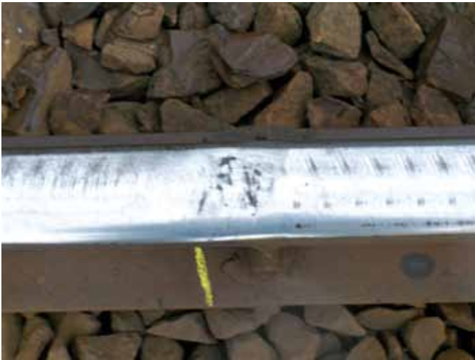
5., 6. Rozwój wady 121 uszkodzenie powierzchni tocznej w torze nr 2 w lewym toku szynowym w km 455,960
