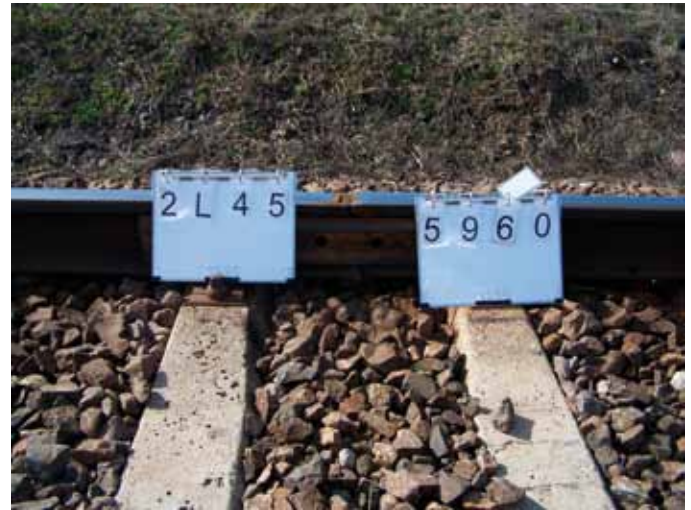
5., 6. Rozwój wady 121 uszkodzenie powierzchni tocznej w torze nr 2 w lewym toku szynowym w km 455,960
