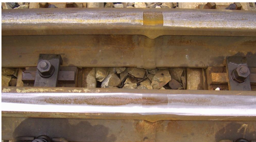
Fot.4. Połączenie iglicy z szyną łączącą spawem termitowym
