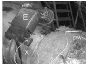
Rys. 1. Układ pomiarowy podczas pracy na rurociągu pary świeżej
