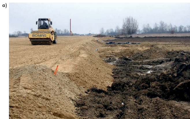
Fot. 2. Dogęszczanie platformy roboczej
