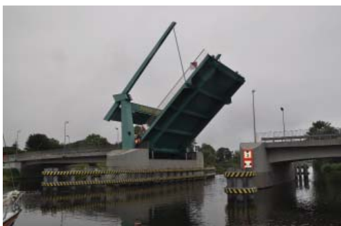
a) Most drogowy w Drewnicy
