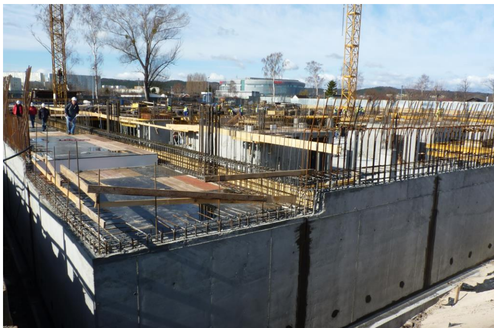
Rys. 2 – Ogólny widok placu budowy
