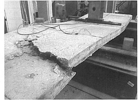
Rys. 9. Płyta nr 3 po zniszczeniu
