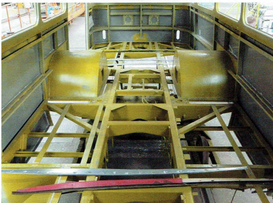
Konserwacja konstrukcji po zakończeniu prac naprawczych
