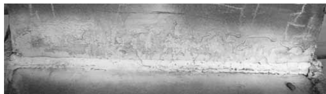
Rys. 6. Złącze próbne 3FW. Widoczne nierówne lico spoiny
