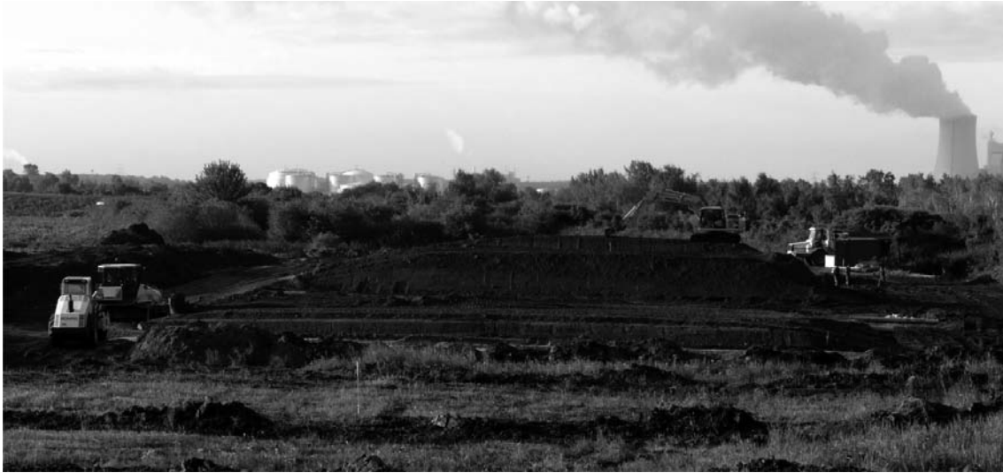
Rys. 7. Budowa wałów poprzecznych w sierpniu 2011 r.
