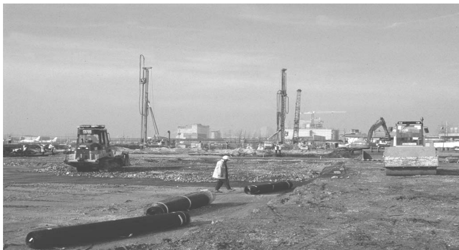
Rys. 7. Platforma robocza na placu budowy Royal Docks w Londynie [5]
