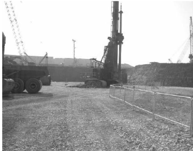
Rys. 6. Prawidłowe zabezpieczenie terenu budowy – niemożliwy wstęp (właściwe ogrodzenie) na niedokończony obszar platformy [4]
