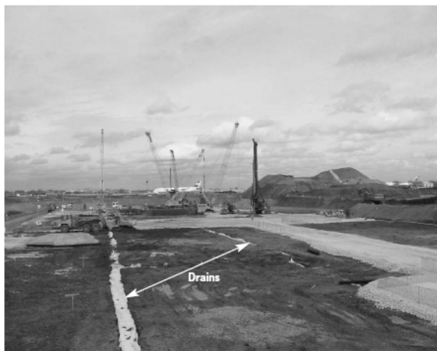
Rys. 3. Ochrona podłoża przez odpowiedni drenaż [4]
