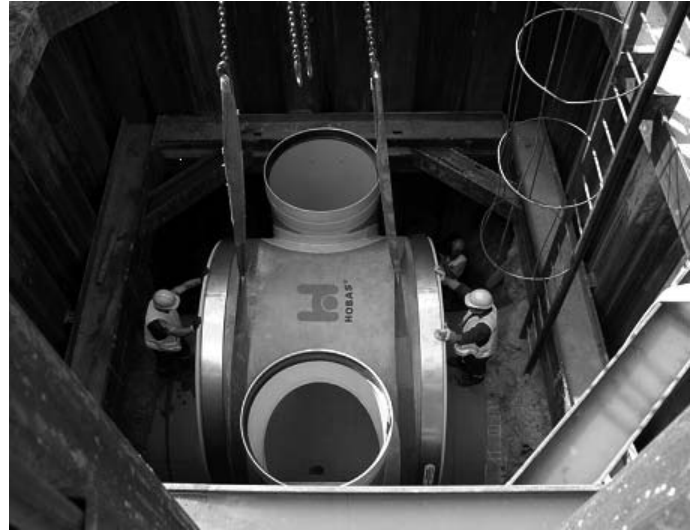
Rys. 5. Studzienka rewizyjna (GRP) wprowadzana do wnętrza komory dopiero po ukończeniu wierceń (materiały firmy HOBAS)
