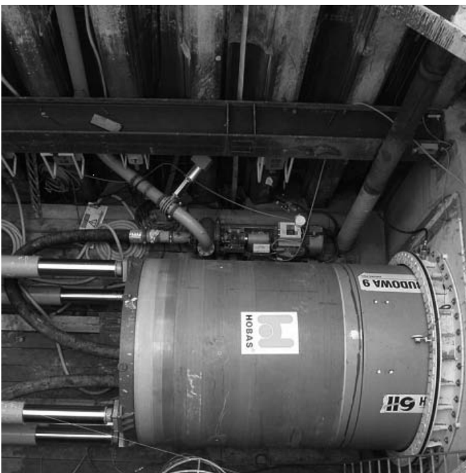
Rys. 4. Wprowadzanie kolejnej rury (materiały firmy HOBAS)
