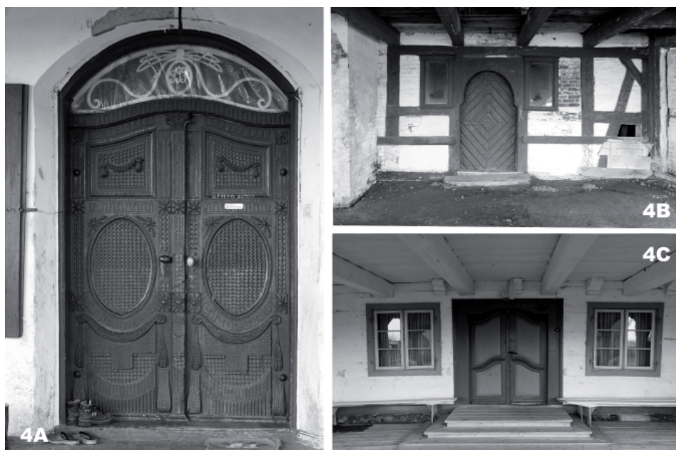
Fot. 4. Historyczne detale stolarki: 4A – empiorowe drzwi domu w Żłotowie (1790 r.), 4B – drzwi deskowo-klepkowe Nowa Kościelnica (1750 r.), 4C – barokowe drzwi w Rozgarcie (1749 r.).
