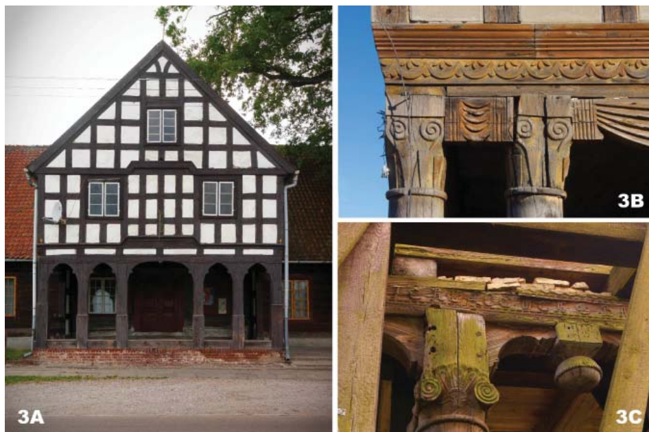
Fot. 3. Detale konstrukcji: 3A – Nowy Staw (1820 r.), 3B – Nowa Kościelnica (1840 r.), 3C – Marynowy (1804 r.)
