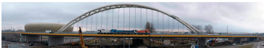
Rys. 7. Ustawienie U2 obciążenia próbnego
