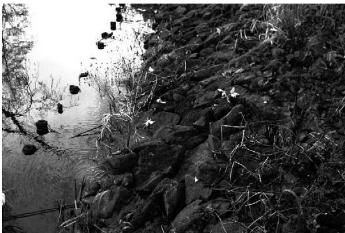
Rys. 10. Umocnienie brzegu narzutem kamiennym. Schemat istniejącej konstrukcji
