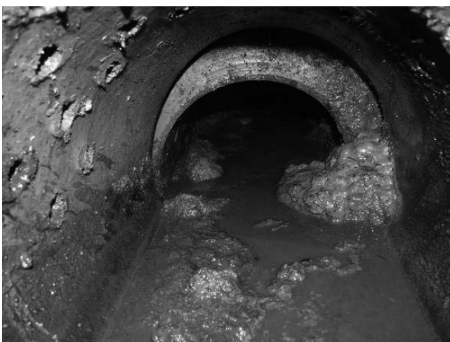
Rys. 14. Ogólny stan zniszczonego drenażu po prawej stronie budynku elektrowni
