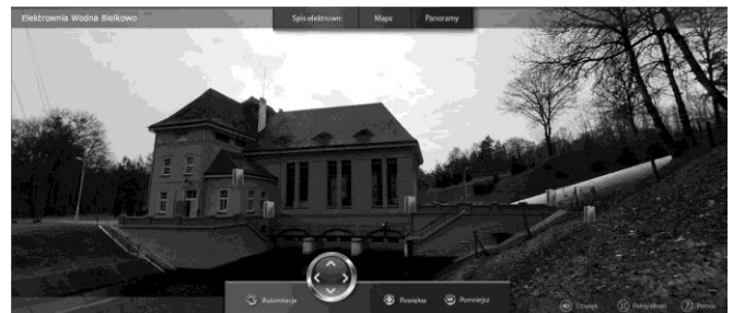
Fot. 1. Wirtualne zwiedzanie elektrowni wodnej Bielkowo [1]
