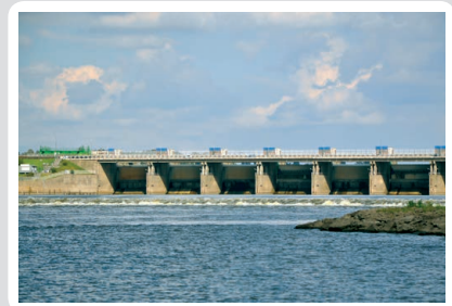
Fot. 6. Stopień wodny Włocławek widok od strony wody dolnej, fot. P. Jerzyło
