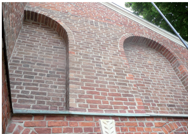
Il. 3. Wnęki znajdujące się w części górnej ściany wschodniej dawnego budynku gospodarczego. Należą one do jedynych średniowiecznych detali, jakie się zachowały. Stan z 2010 r. (fot. A. Piwek)
