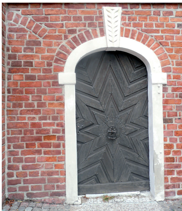
Il. 7. Dawne wschodnie wejście do parteru dawnego budynku gospodarczego po zmianach dokonanych w 1824 r. (fot. A. Piwek)
