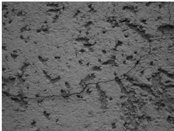
Rys. 1. Uszkodzenia powstałe na skutek drgań komunikacyjnych (fot. własne)
