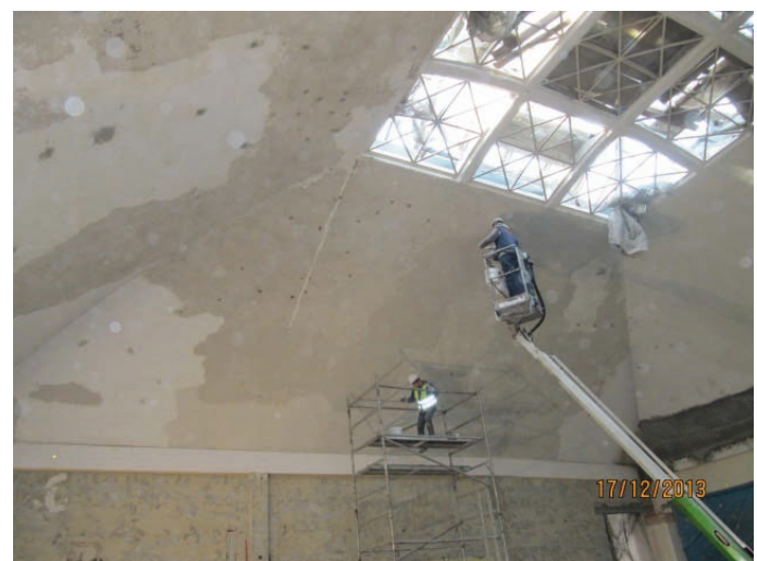
Rys. 12. Naprawa ubytków betonu wewnętrznej powierzchni powłoki kopuły, widok od strony zachodniej (zdjęcia autorów – 17.12.2013)
