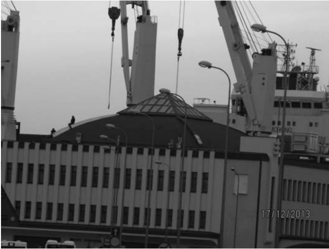
Rys. 33. Prace przy ociepleniu żeber kopuły Dworca Morskiego w Gdyni (17.12.2013)
