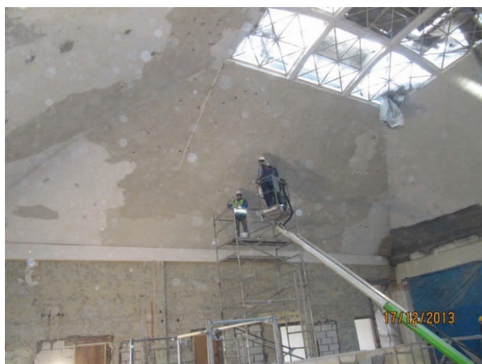
Rys. 12. Naprawa ubytków betonu wewnętrznej powierzchni powłoki kopuły, widok od strony zachodniej (zdjęcia autorów – 17.12.2013)
