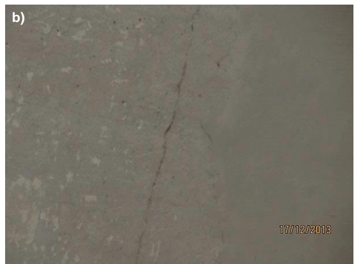
Rys. 11. Zarysowanie powłoki od strony Nabrzeża Holenderskiego a) widok zarysowania powłoki od strony południowej, b) szczegół rysy (zdjęcia autorów – 17.12.2013)
