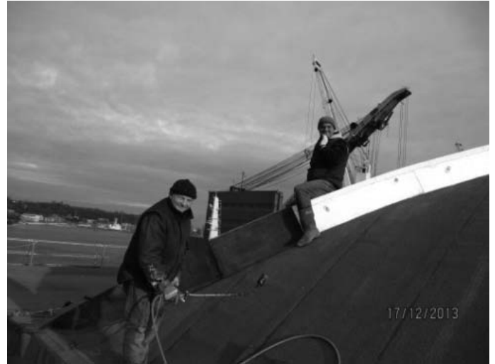
Rys. 33. Prace przy ociepleniu żeber kopuły Dworca Morskiego w Gdyni (17.12.2013)
