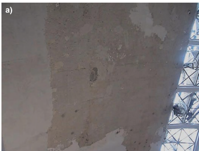
Rys. 11. Zarysowanie powłoki od strony Nabrzeża Holenderskiego a) widok zarysowania powłoki od strony południowej, b) szczegół rysy (zdjęcia autorów – 17.12.2013)
